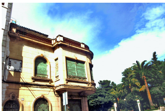
Detalle de la fachada lateral de la casa de don José Pertejo recayente a la antigua calle General Moscardó (act. Pi y Margall) en la que se observa el característico reloj de Sol y la fecha de su construcción (1951).
