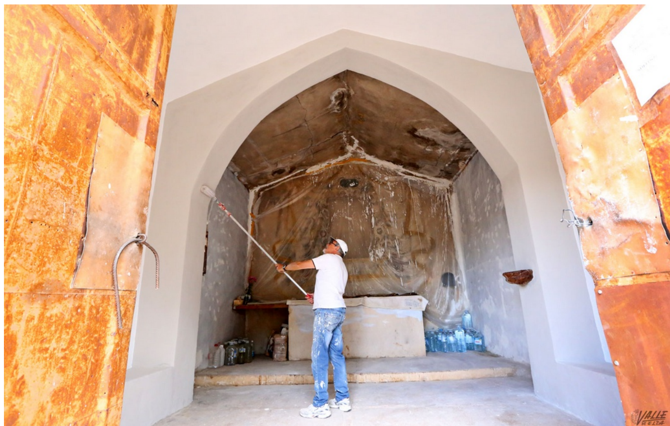
Los trabajos se aprecian a simple vista | Jesús Cruces.
