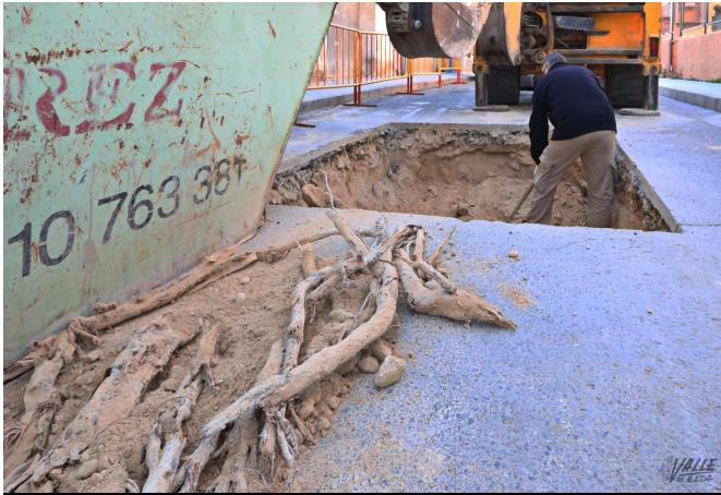
Los operarios están retirando las raíces que obstruyen el alcantarillado | Jesús Cruces,
