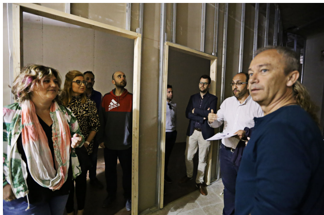
La corporación municipal ha visitado la primera fase de las obras | Jesús Cruces.
