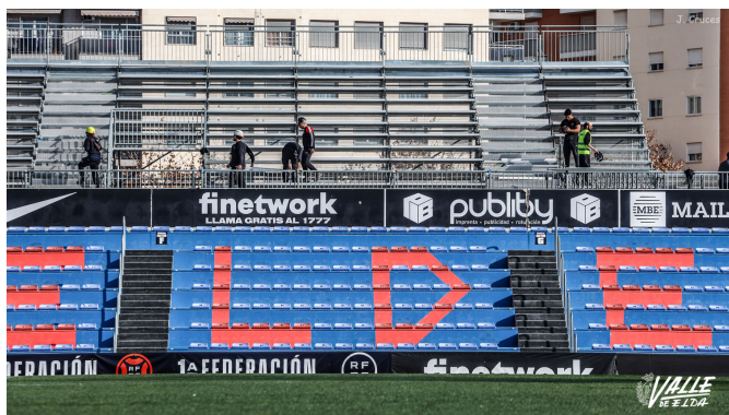
Los trabajos para levantar la grada extra continuaban esta misma tarde | J. Cruces.
