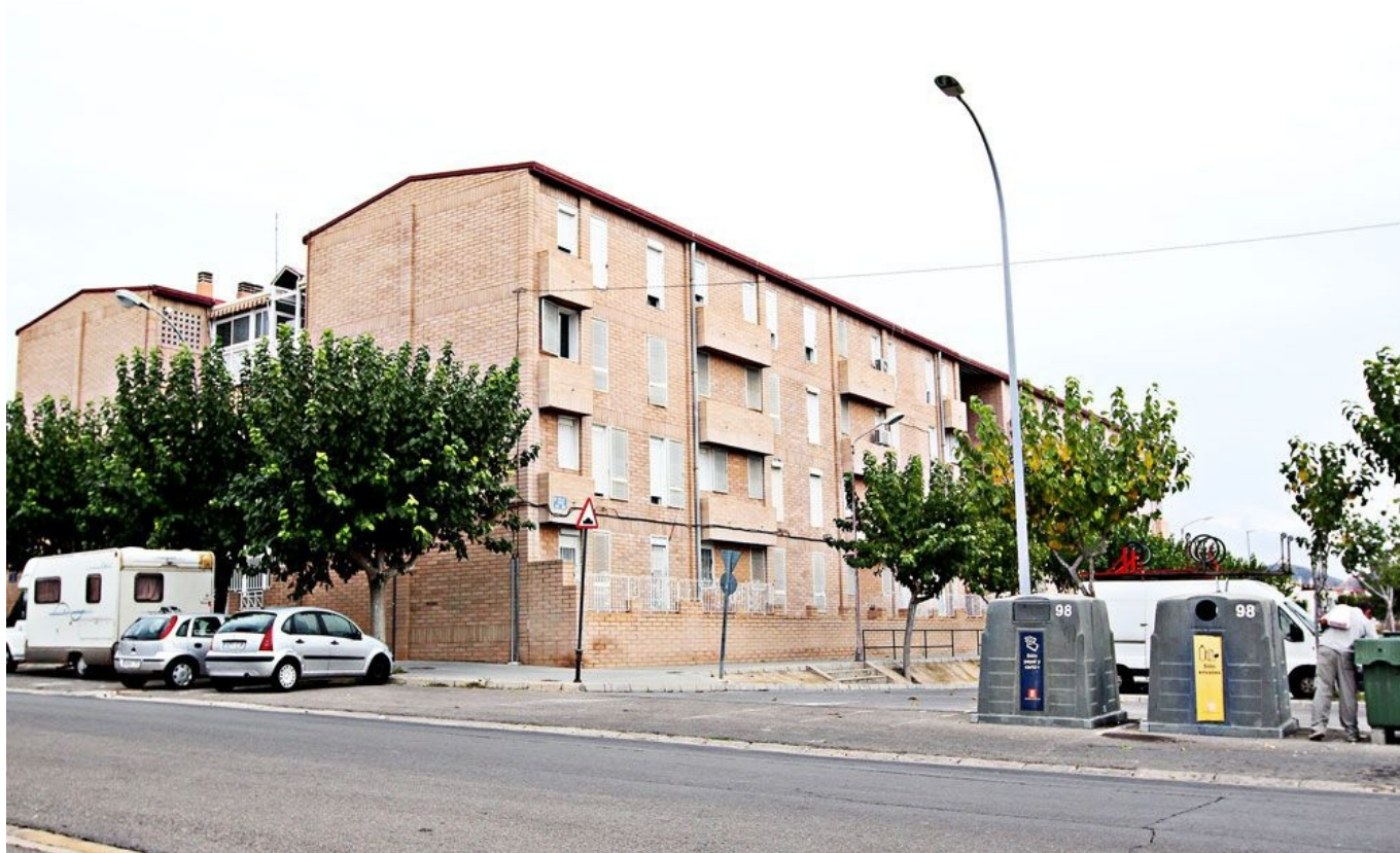
Las viviendas están situadas junto al instituto La Torreta | Jesús Cruces
