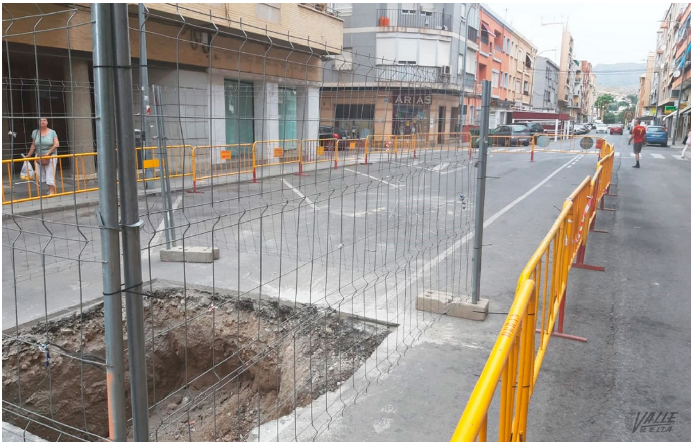
Imagen del socavón que se está reparando.
