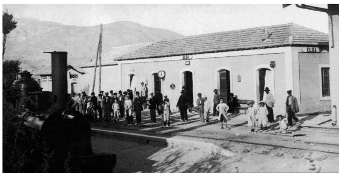
Antigua estación de ferrocarril de Elda, demolida en 1932.
