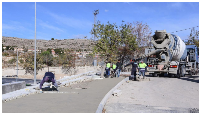
Ahora las labores están centradas en la urbanización de la zona.
