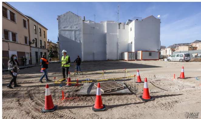
La obra estará concluida en mayo y se podrá visitar| J.C.
