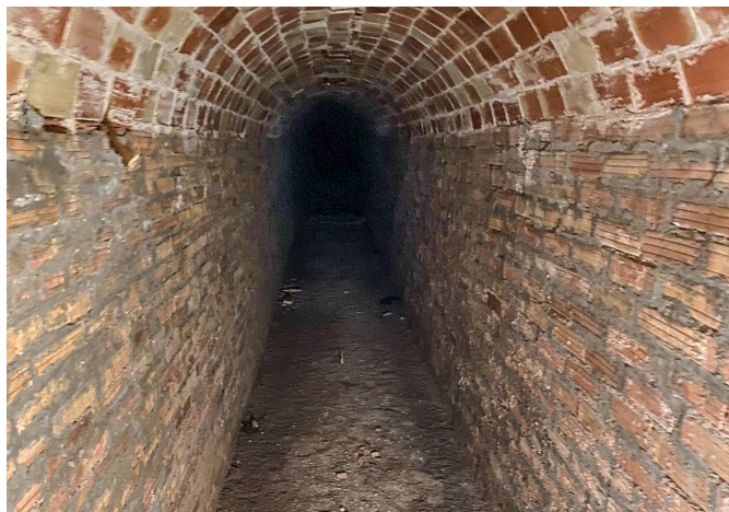
Imagen del túnel.
