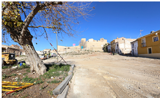
Los trabajos se están llevando a cabo para mejorar la zona | Jesús Cruces.
