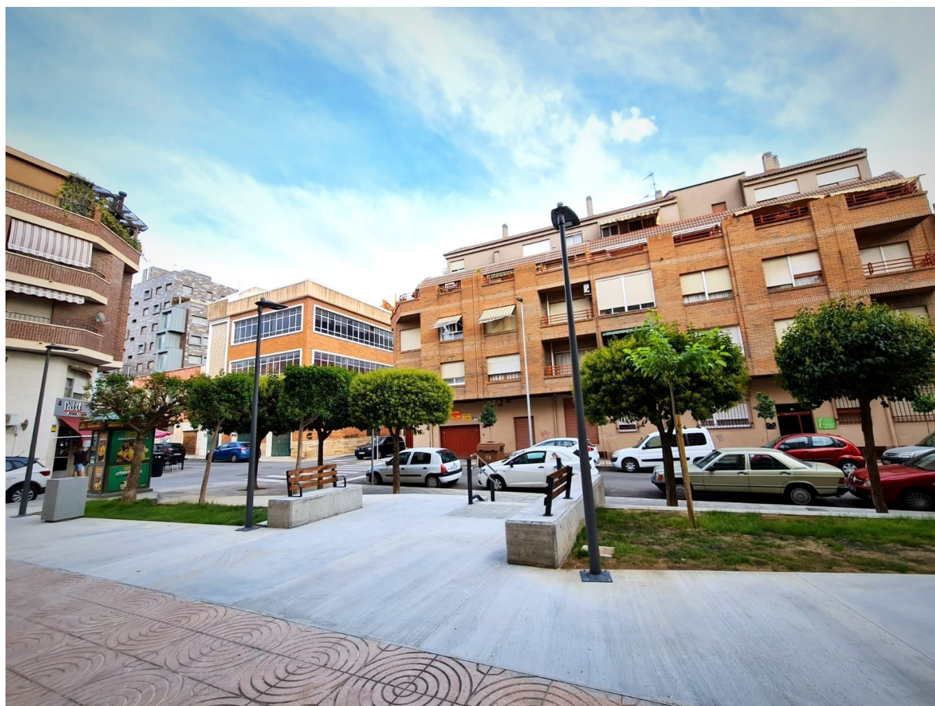
La plaza cuenta con una nueva rampa para personas con movilidad reducida. Foto del Ayuntamiento de Elda
