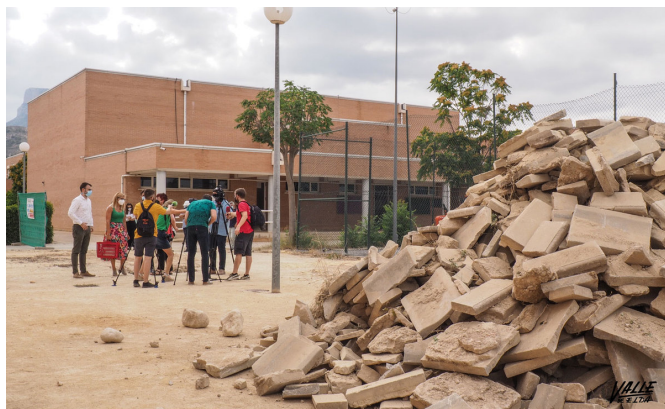
Las obras tendrán un plazo de ejecución de 15 meses.
