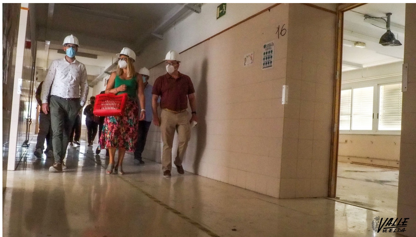
El equipo de gobierno ha acudido a visitar las obras.
