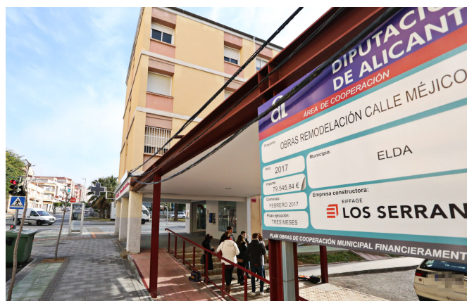
Las obras se realizaron a mediados de 2017 | Jesús Cruces.
