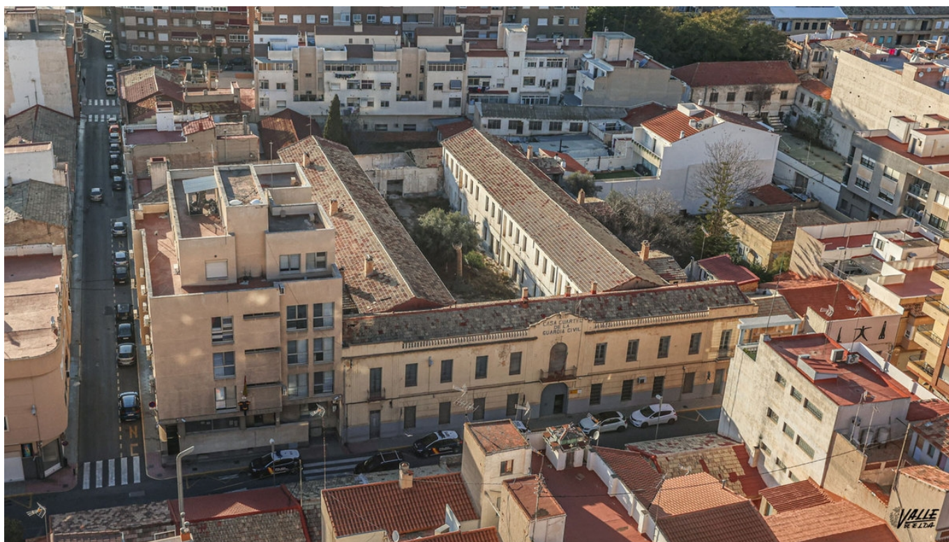
La Casa-cuartel solo acoge actualmente a tres agentes de la Guardia Civil | J.C.
