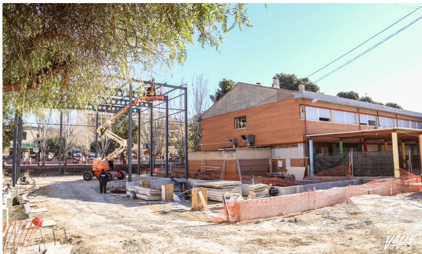
Las obras avanzan a buen ritmo.
