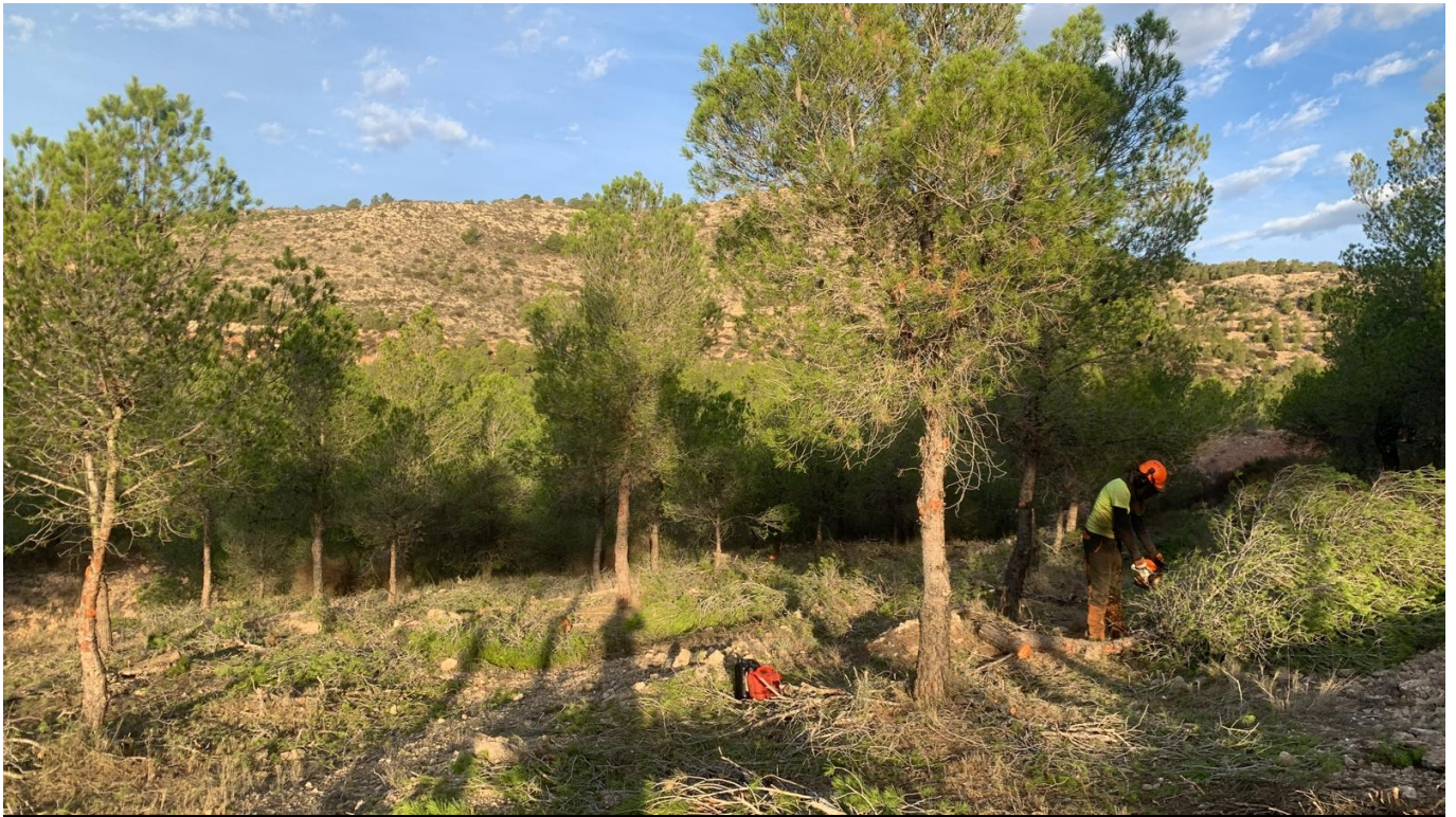
Imagen de los trabajos | Ayuntamiento de Elda.
