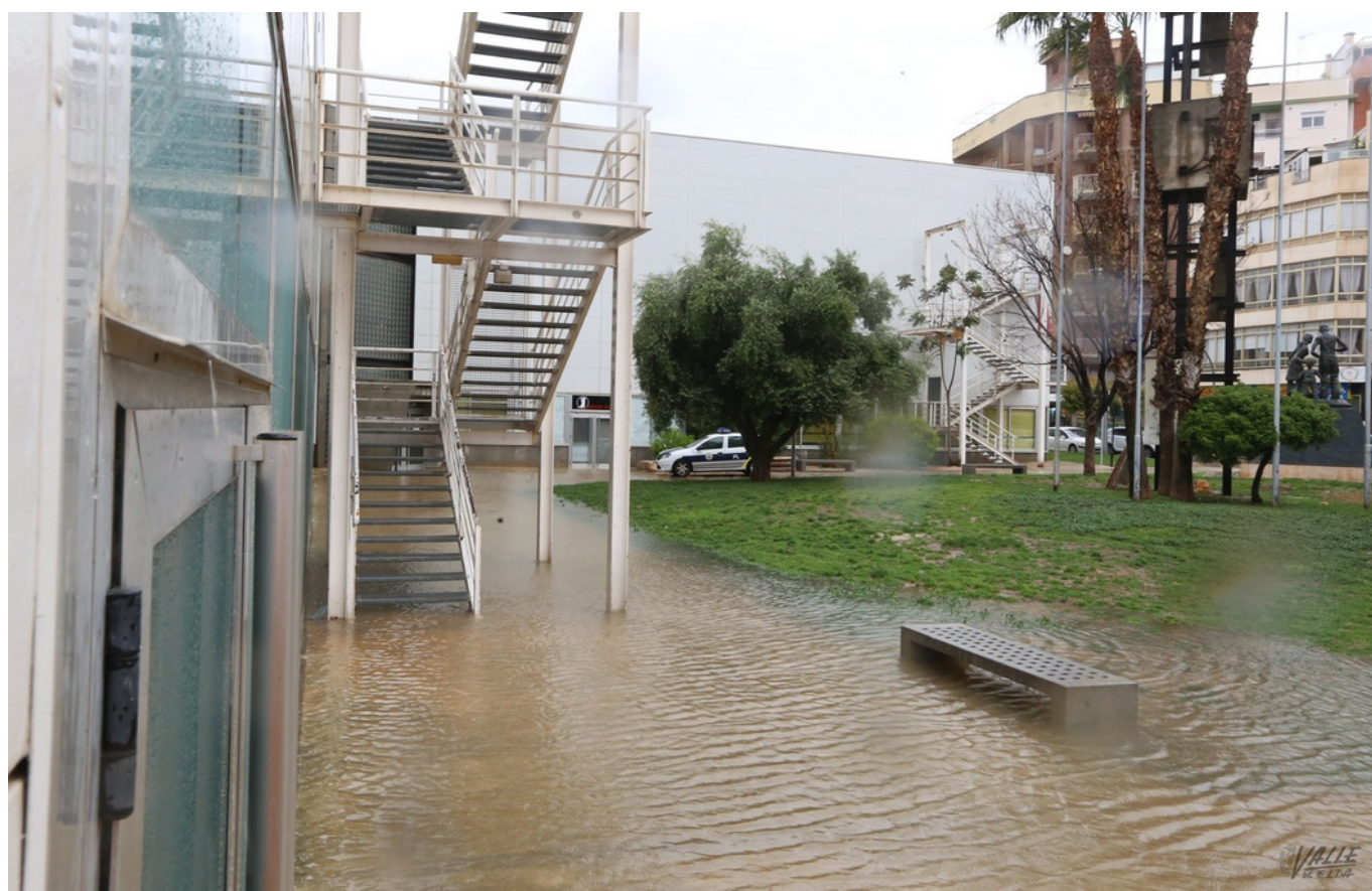
La entrada y una sala del Museo del Calzado se ha inundado.
