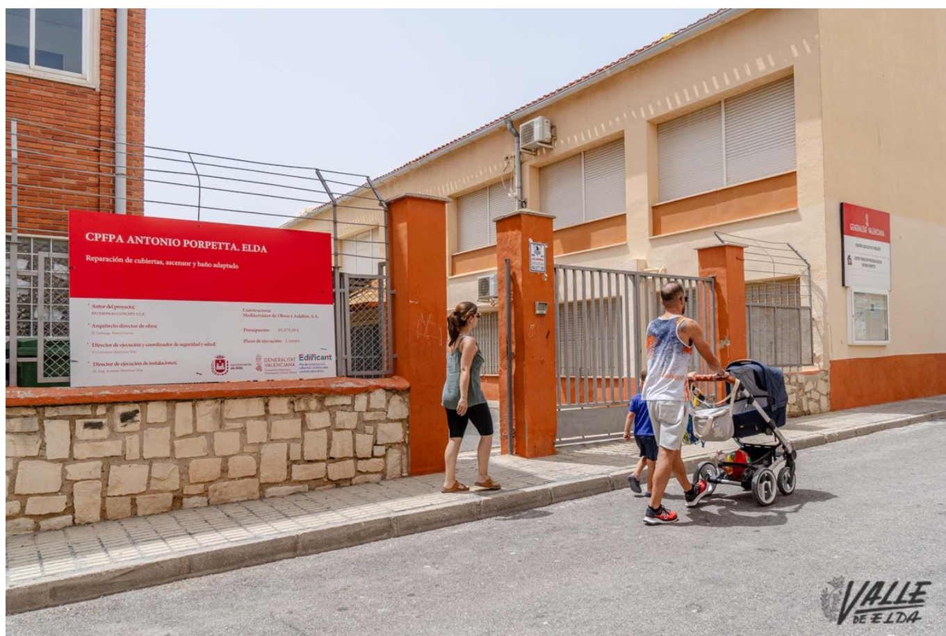
Las obras ya han comenzado en este centro | Nando Verdú.
