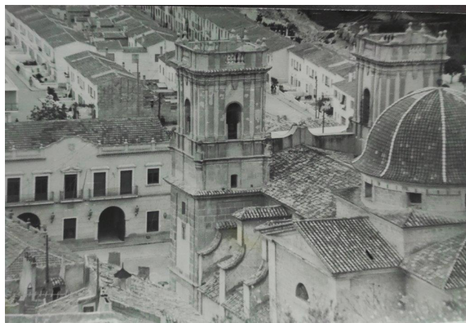
El edificio de ayuntamiento con las puertas del mercado y el ayuntamiento se inauguró en las fiestas patronales de 1951. Foto: José Esteve.
