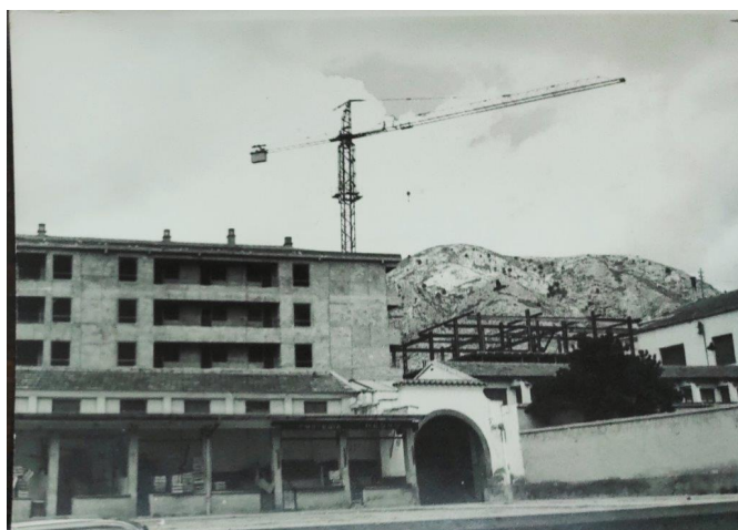
Entrada al mercado por el Derrocat. En construcción los pisos de la calle Constitución y los de Carreró de la Bassa. Foto: José Esteve.
