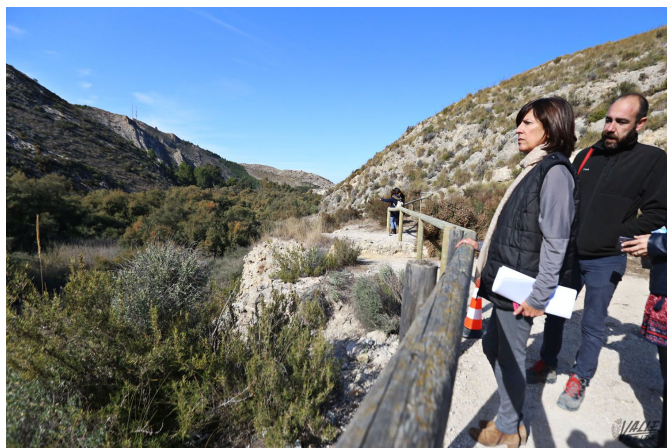
También se ha instalado una barandilla de madera en la zona | Jesús Cruces.
