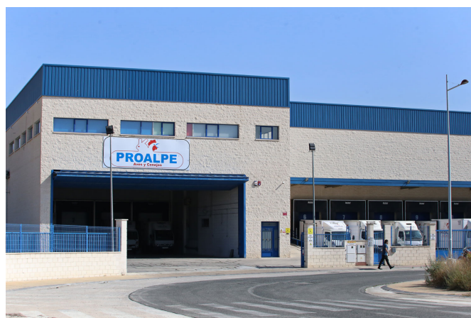
Las instalaciones de la empresa Proalpe se encuentran en el Polígono Industrial Finca Lacy de Elda.
