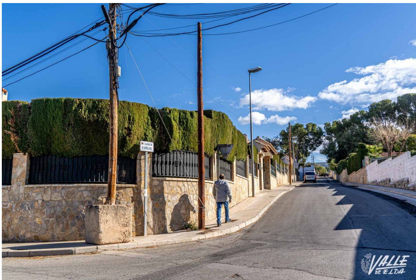
Los postes, que aguantan el cableado, están plantados en una base de hormigón | Nando Verdú.
