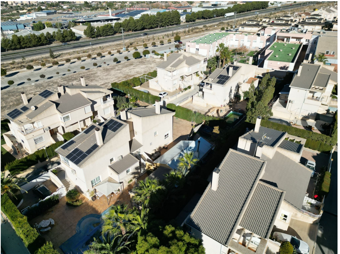
Imagen de viviendas con placas solares.
