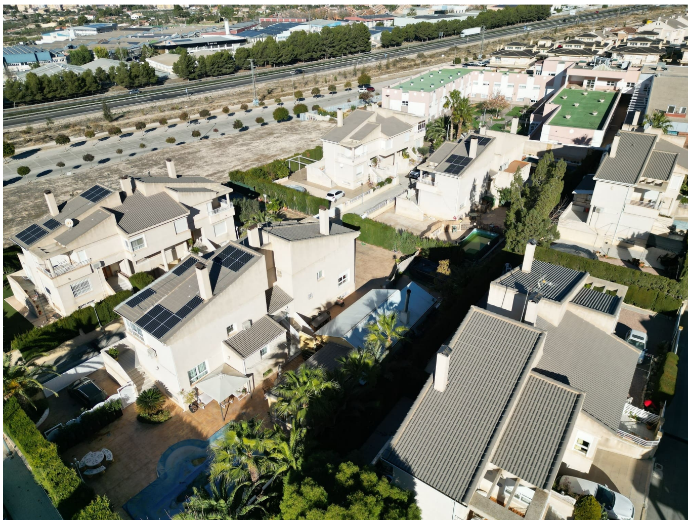
Imagen de viviendas con placas solares.
