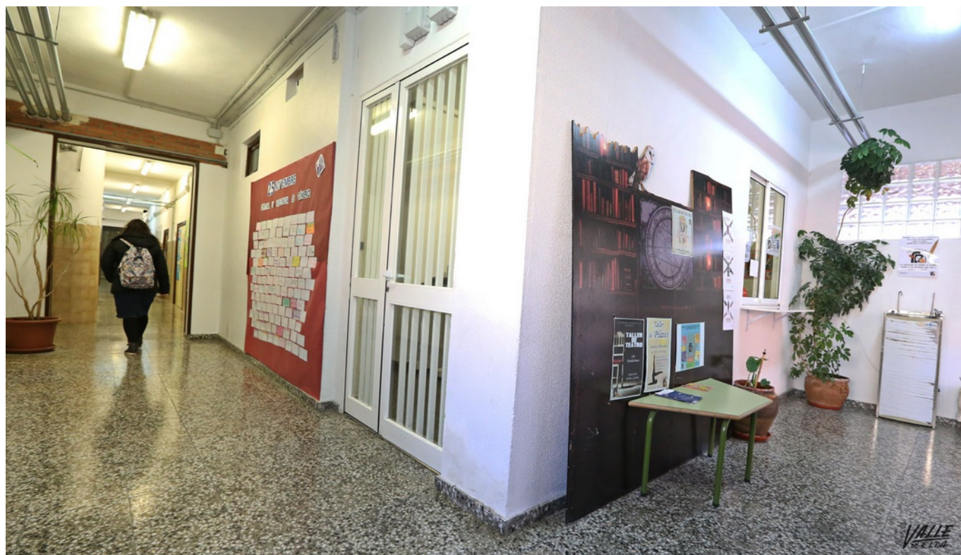
El centro tendrá un ascensor, nuevos aseos y se eliminarán las goteras | Jesús Cruces.
