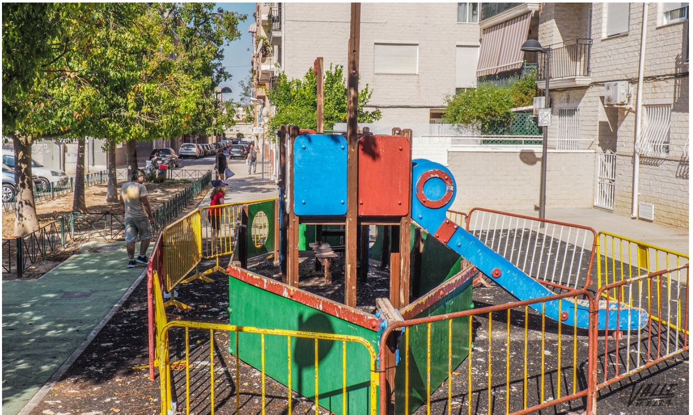
Una de las zonas que se repararán será la del conocido como parque del barco.
