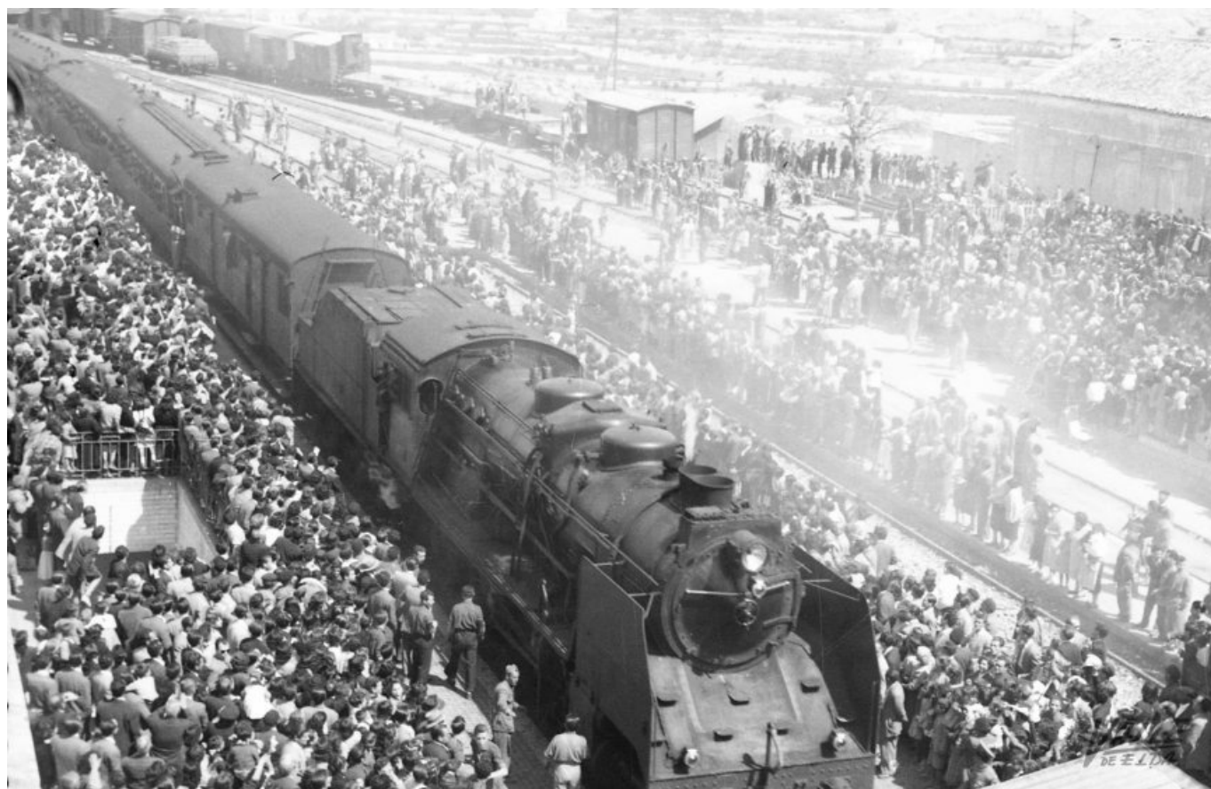
El tren haciendo su entrada en la estación de ferrocarril de Elda .
