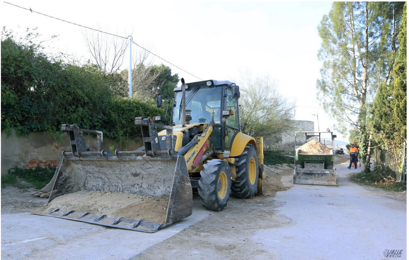
El camino se ha cortado en múltiples ocasiones para llevar a cabo las obras.
