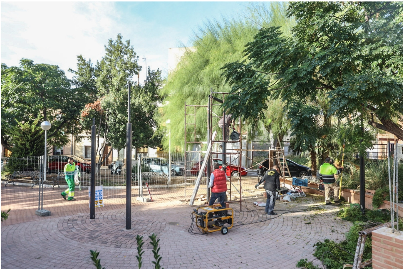
Actualmente se están terminando los trabajos en la plaza.
