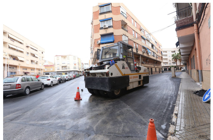
Estos trabajos tienen un presupuesto de 330.000 euros | Jesús Cruces.
