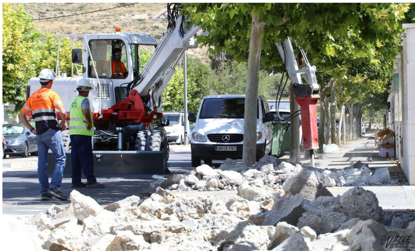
Imagen de las obras de Campo Alto.
