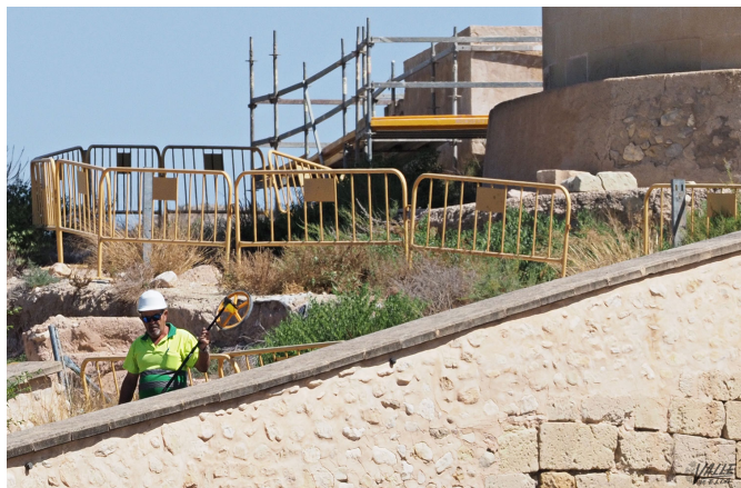
Las obras podrían concluir a principios de 2019 | Jesús Cruces.
