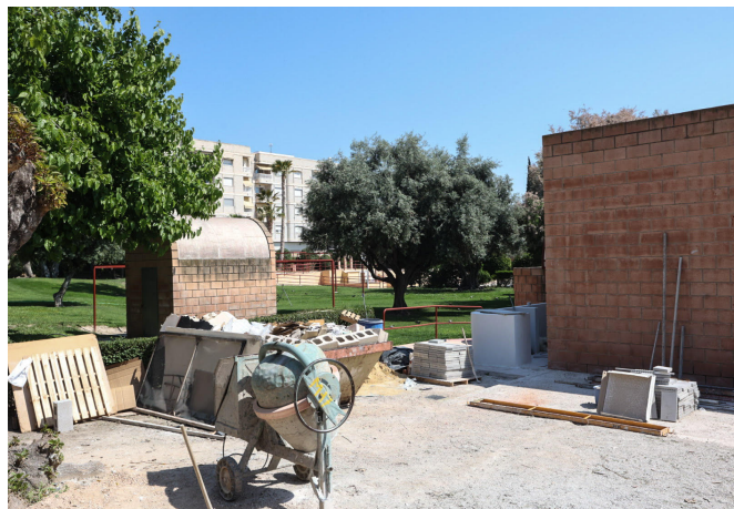
Tras las obras se adjudicará la cantina.
