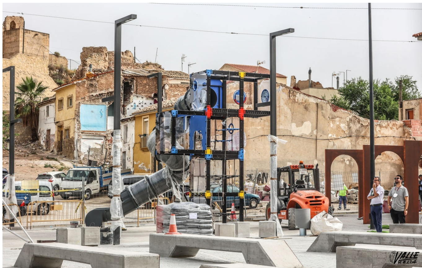
La instalación de los juegos infantiles comenzó ayer.
