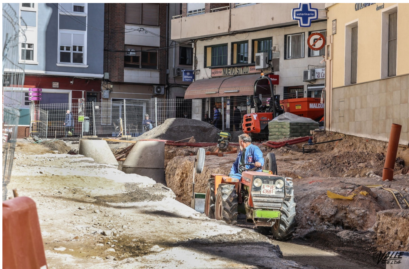
Los trabajos continúan en El Derrocat de Petrer | J.C.
