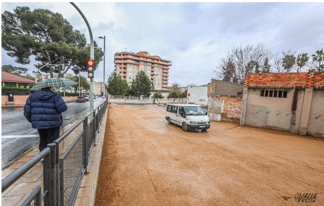
Los trabajos se realizarán para mejorar el aparcamiento.
