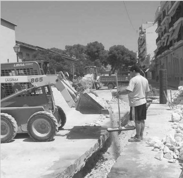
La sustitución de un tramo en la red de alcantarillado en la calle Calvario y Paseo de la Explanada ha puesto en evidencia el estado general de este servicio. Se han puesto al descubierto una serie de deficiencias en el trazado que durante mucho tiempo han producido continuas fugas y como consecuencia muchas humedades. Los tubos no tenían la suficiente incli-
