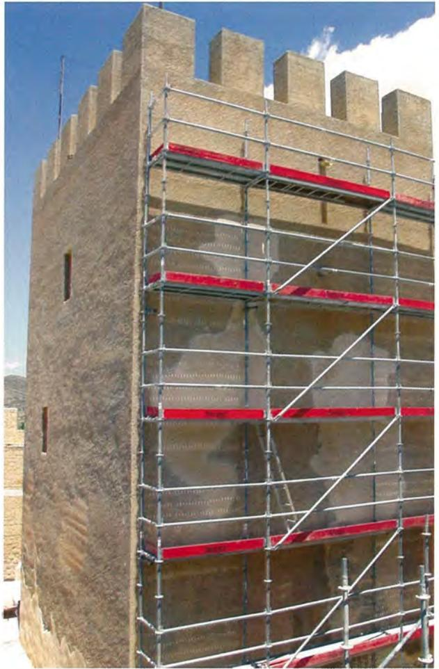
original de la fortaleza, sino que se perseguía consolidar la volumetría de mampostería del castillo, eliminando los elementos de tapial de difícil conservación, como podía ser la tercera planta de la torre, o las almenas y merlones de la muralla perimetral, como se puede apreciar en fotografías previas a la restauración.
