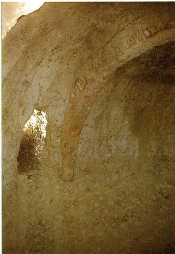
amb un grossor de 0'70 metres inicia la volta o cupula hemisfèrica, la qual es recolza sobre un arc del mateix tipus d'obra que surt a l'interior en direcció NE-SW, coincident amb dos dels quatre contraforts exteriors que suporten les presions de la volta.
