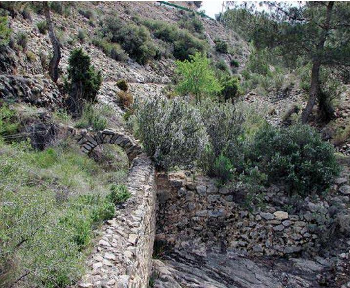
Segundo parat en la rambla del Catxuli. En la foto se aprecia el arco de piedra construido al inicio de la boquera de derivación.
