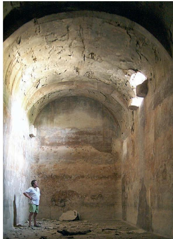
El Aljub Monumental del Esquinal (15 m. de largo, 6 m. de ancho y 5 m. de alto) es la mayor cisterna de almacenar agua de lluvia de nuestro término. En la primera foto se observa el sistema de entrada del agua y en la segunda las dimensiones del interior.
