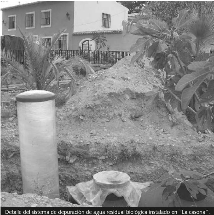
Detalle del sistema de depuración de agua residual biológica instalado en "La casona".
