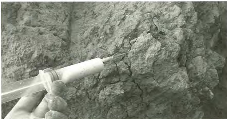
Figs. 9 y 10. Estado de conservación de la bóveda del *praefurnium* y consolidación y fijación de fisuras.
