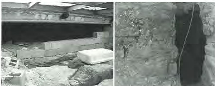
**Figs. 4 y 5. Estado de la zona trasera del horno previo al inicio de los trabajos de restauración y detalle de las colonias de líquenes en los arcos de la cámara de combustión.**
