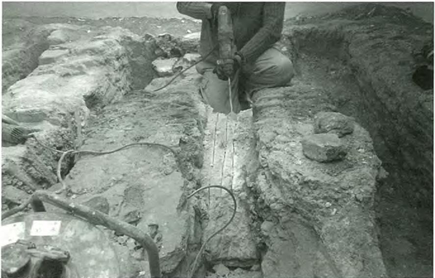
Fig. 8. Eliminación de los vertidos de hormigón.
