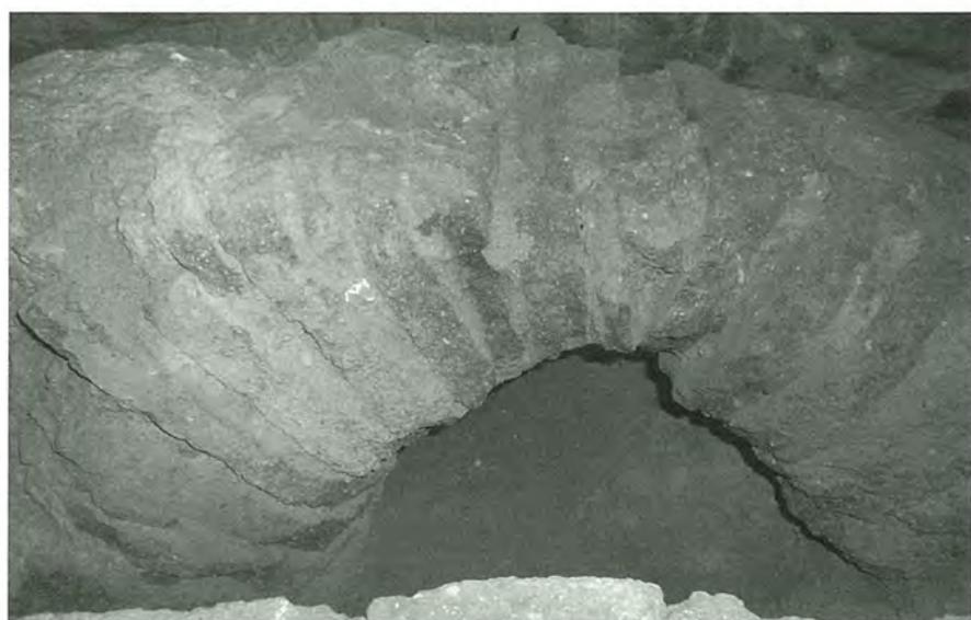
Figs. 11 y 12. Proceso de restauración de la bóveda del *prae-furnium* y detalle del rejuntado de los arcos de la cámara de combustión.
