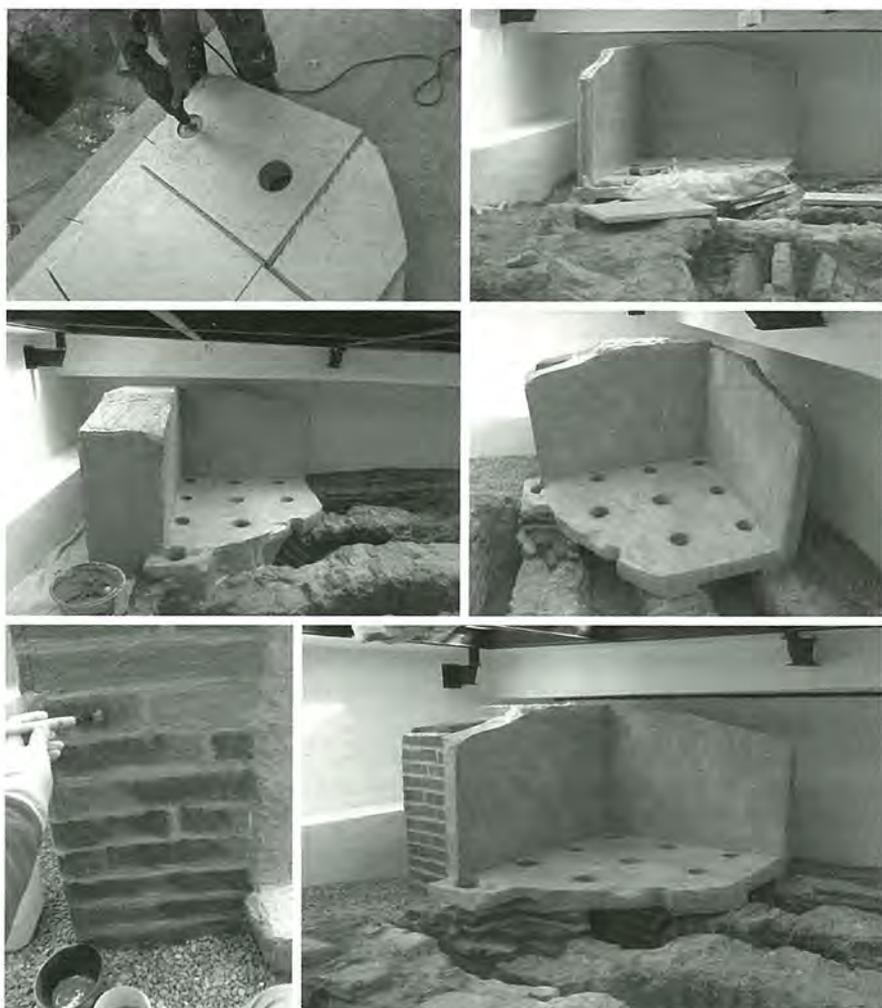
Fig. 15. Proceso de construcción de la recreación de la esquina de la cámara de combustión.
