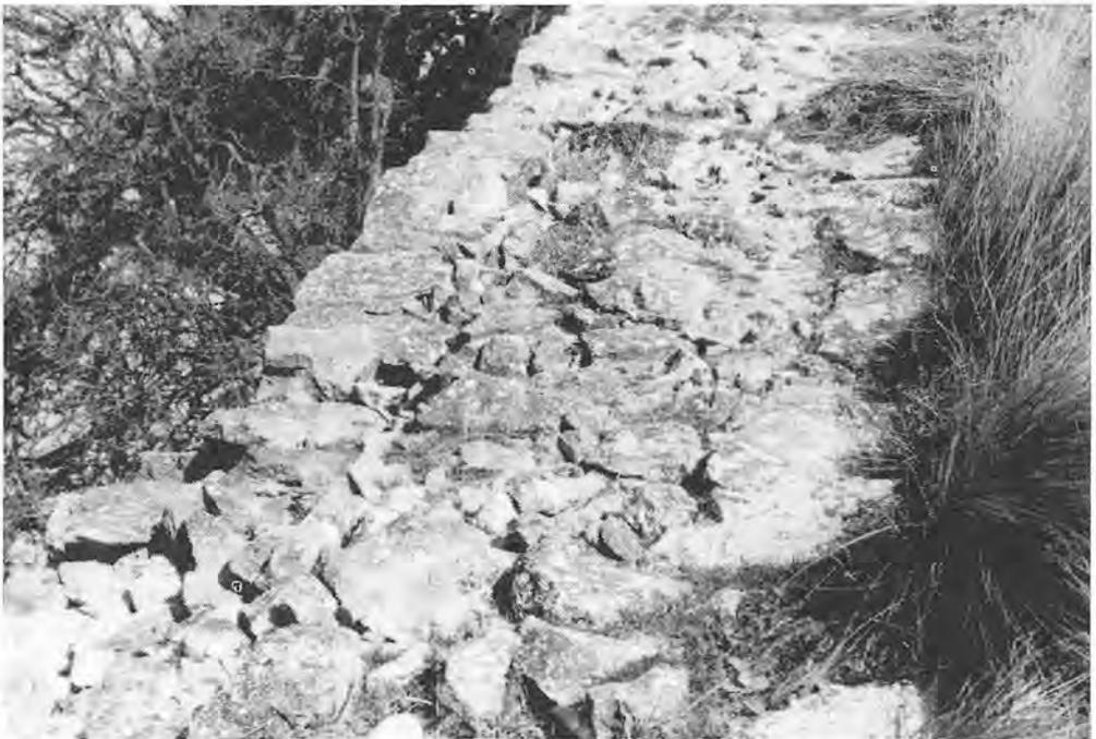
Parat de Catxuli. Coronación del muro donde se aprecia la estructura de doble pared y relleno interior
