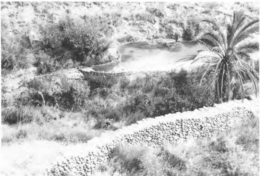
Barranc de la Sarsa. Una balsa que carga aguas mediante un azud en su parte media. Muros de defensa contra avenidas en la margen derecha (febrero, 1989)
