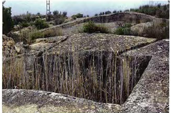
Figuras 5 y 6: Canal excavado en la roca para conducir el agua de escorrentía a la balsa, también tallada en la roca. Partida de Coxinets.
